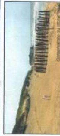
Plage au droit du Platier d'Oye La mise en place de castors en haut de plage vient compléter le dispositif d' épis implantés en 1996. Leur rôle est de réduire l'énergie des houles afin de favoriser l'accumulation de sable en haut de plage et ainsi réduire le recuit du trait de côte.
