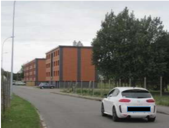
Vue de la résidence qui est en zone rouge
