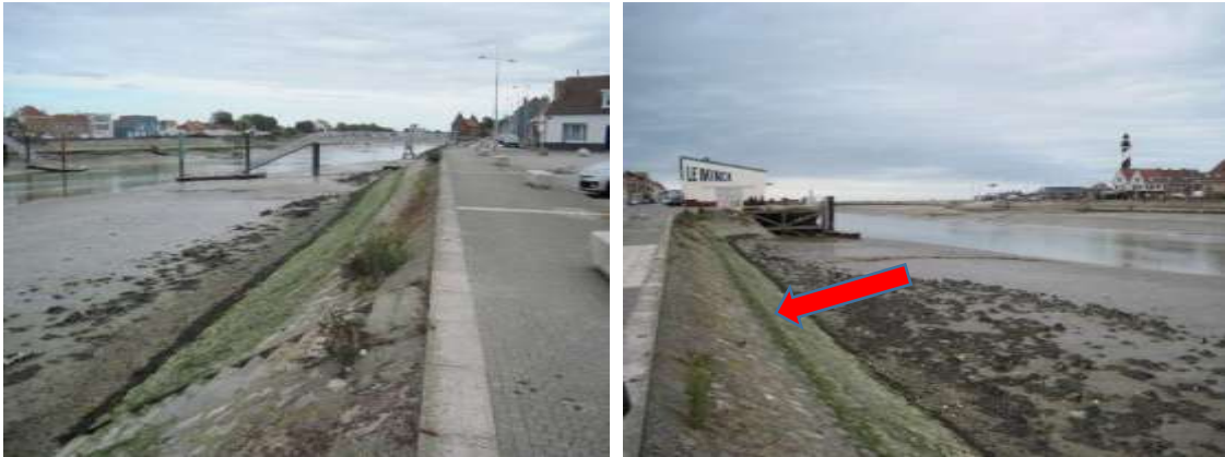
Vues générales du chenal de l'Aa à partir de la place qui est le point débordement de la commune. On voit nettement la hauteur d'eau à marée haute (flèche).
