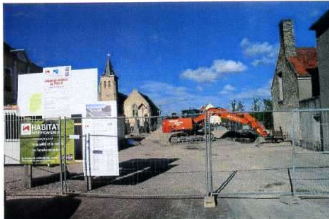
Le chantier de la future maison médicale vient de débuter. Il est compris dans le projet, plus global, de réaménagement de la Grand'Place.
